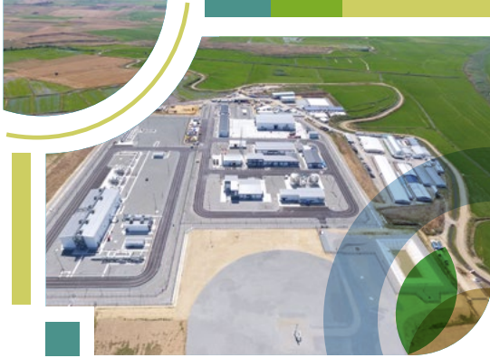
Metering Station (MS-4) Edirne
