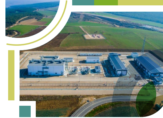
Metering Station (MS-3) Edirne
